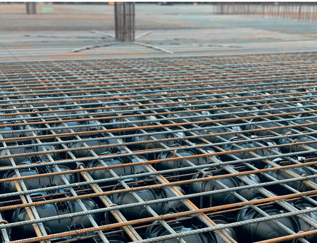
Vor allem in mehrstöckigen Gebäuden mit großen Decken, Balkonen und Fundamenten mit Dicken zwischen 18 und 50 cm sind die Verdränger sinnvoll. Mit ihnen können Bauherren bis zu 40% Beton einsparen. © Unidome
